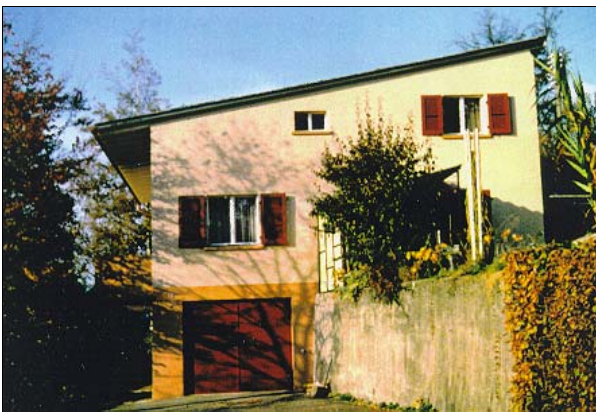
Wohnhaus: Shackfenster rechts oben
